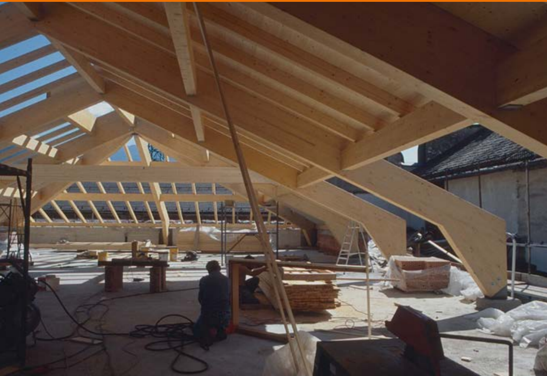
Copertura in legno lamellare dell'edificio ex Enel in via Alfieri, Trento (1996). Stampa da diapositiva APTn, AACF, sc. 20, racc. "Particolari, scale, tettoie".
